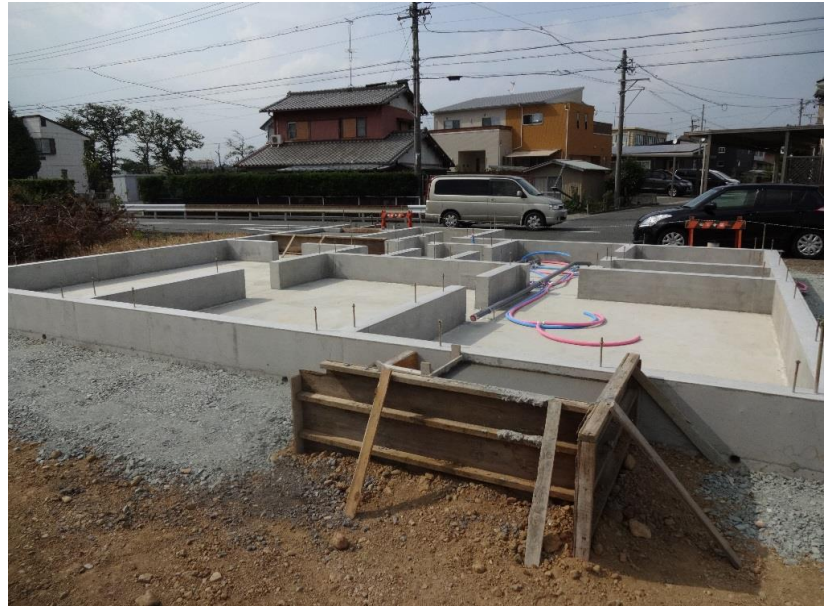
基礎工事完了
