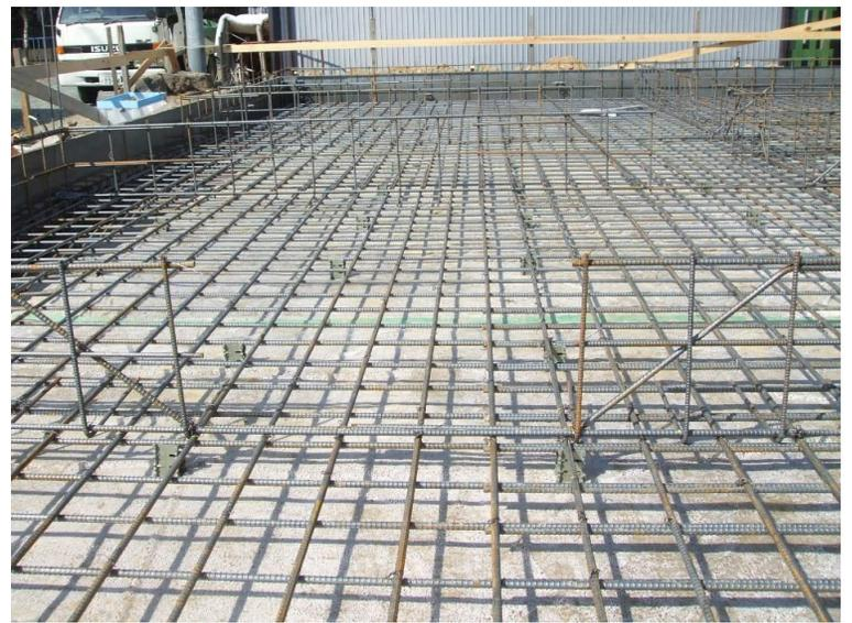
地盤改良をして基礎工事の最初である配筋工事が始まりました。
