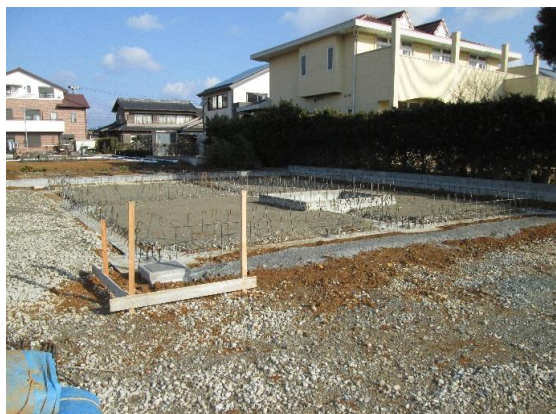
基礎工事 完了
