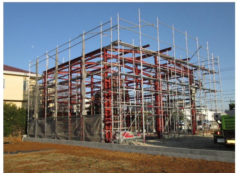
3月2日(月)時点での工事写真
