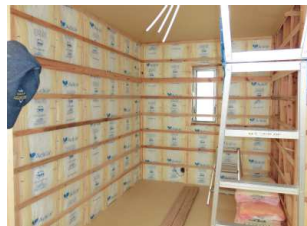
空気循環用仕切り棒の設置 → 内側より断熱材張り 地震に強い落とし蓋工法
