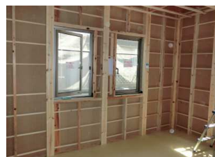
空気循環用仕切り棒の設置 → 内側より断熱材張り 地震に強い落とし蓋工法
