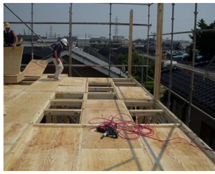
落し蓋工法(溝の部分に28ミリ合板をはめ込み)
