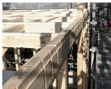
梁の外側を空気が流れます
